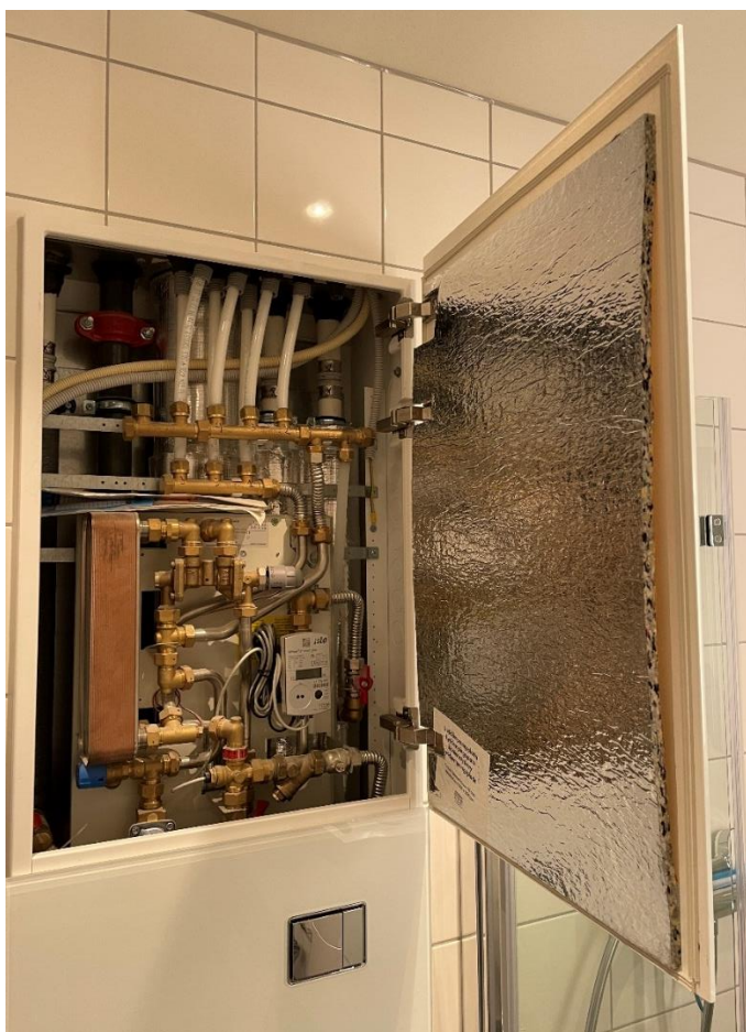
Figur 4: Lydisolerende tiltak på skapdør
