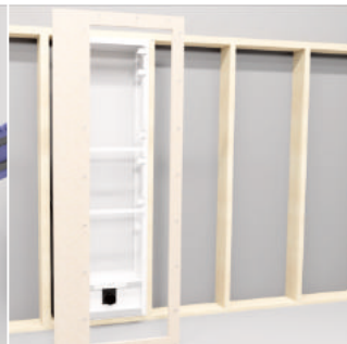
5. Montering av plater
