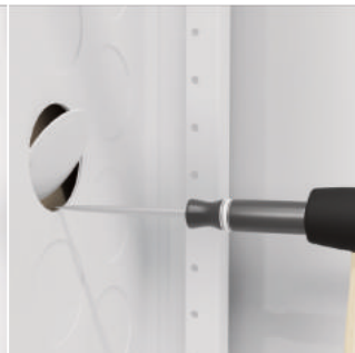
3. Utblokking til rør
