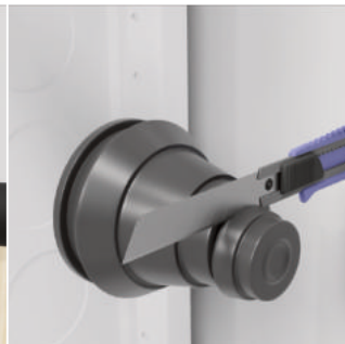
4. Montering av muffer
