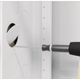
3. Utblokking til rør
